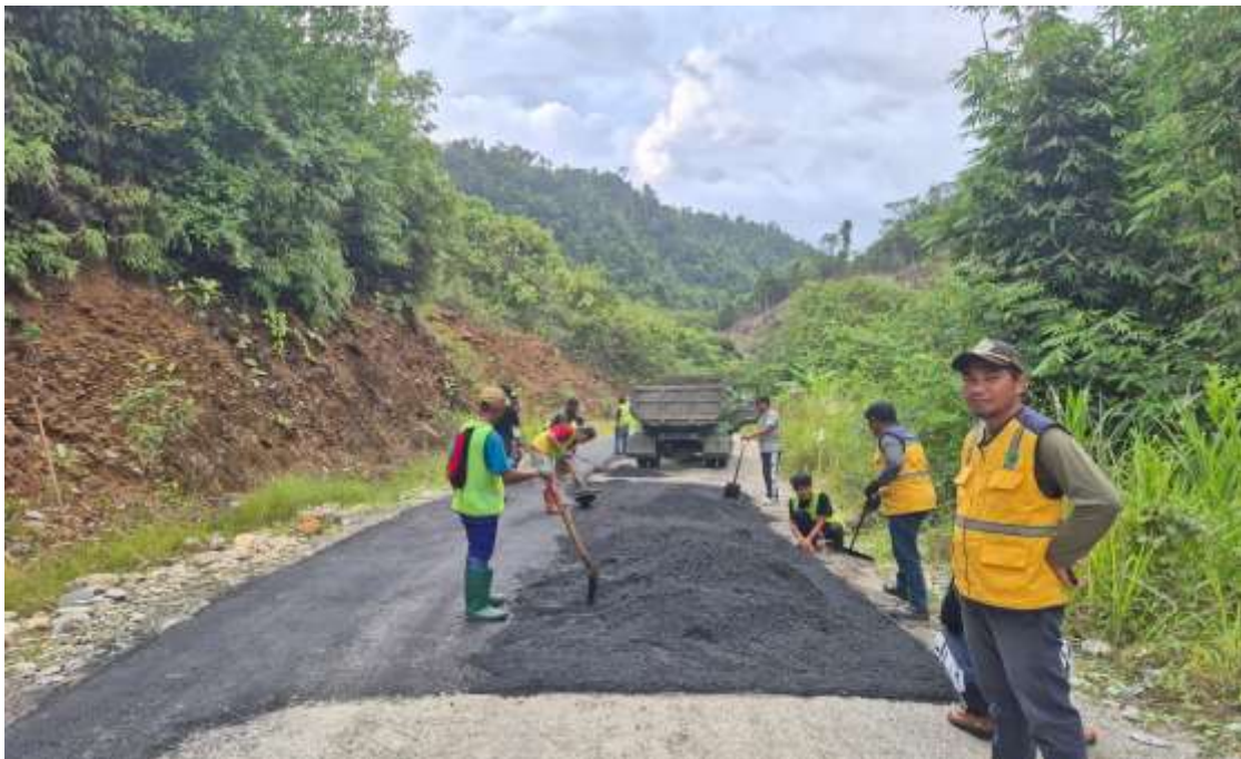
Gambar 2 Pelaksanaan Proyek Jalan di Kabupaten Kolaka Utara (Ruas Jalan Totallang – latawaro)
