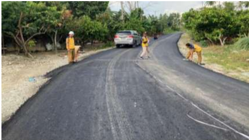
Gambar 1. Penanganan Ruas Jalan di Kab. Kolaka Utara
