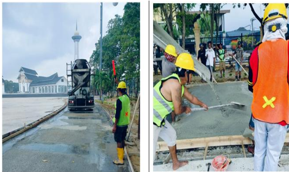
Gambar 2 Penerapan APD dalam menjaga keselamatan kerja pada pekerjaan rehabilitasi kawasan Eks MTQ Kendari Sumber : Data Primer (2025)
